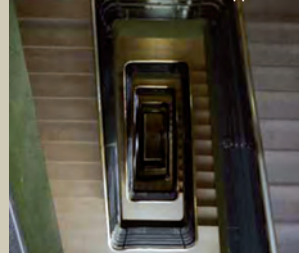
Altes Krankenhaus Schweinfurt Treppenhaus
